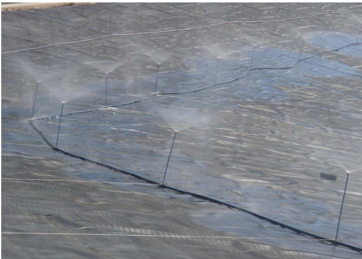
Sistema de aspersão em área impermeabilizada e sujeita aos raios solares.
