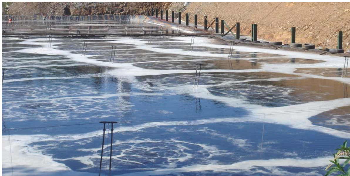
Vista de uma lagoa aerada e impermeabilizada.
