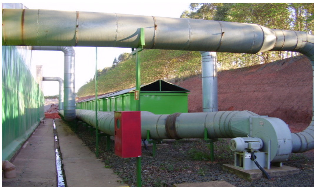
Vista externa (fundos) da Unidade de Biorremediação do CGR-Paulínia: Sistema de exaustão das emissões gasosas provenientes dos galpões. Podem ser observados os dutos de captação.
