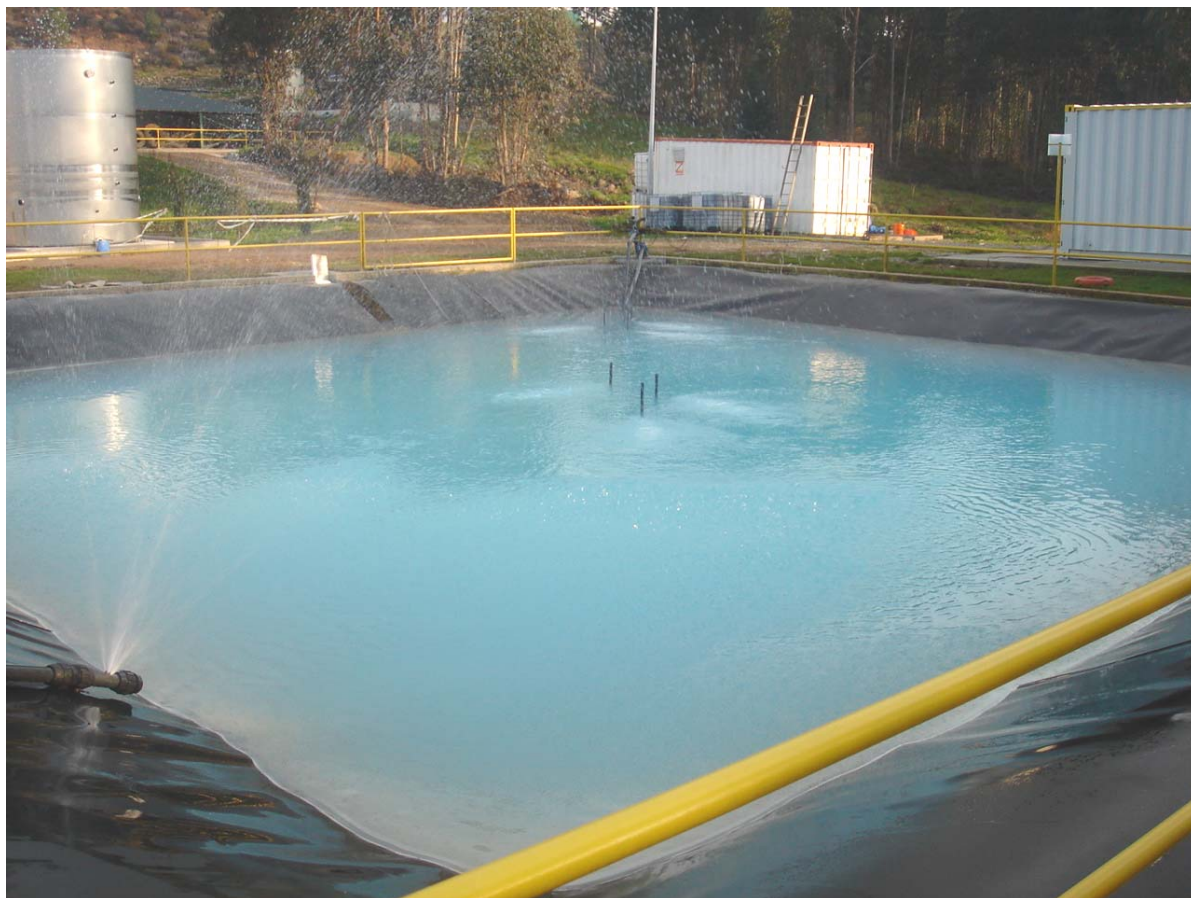
Vista de um tanque de armazenamento de líquidos percolados tratados.
